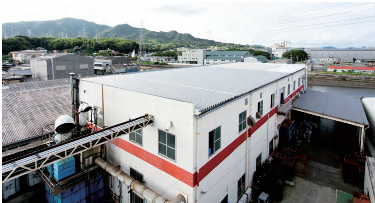
本社工場はニーズに応じて増設・更新
