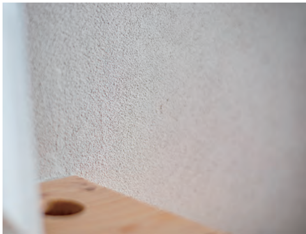
「安芸珪藻土」を用いた壁
